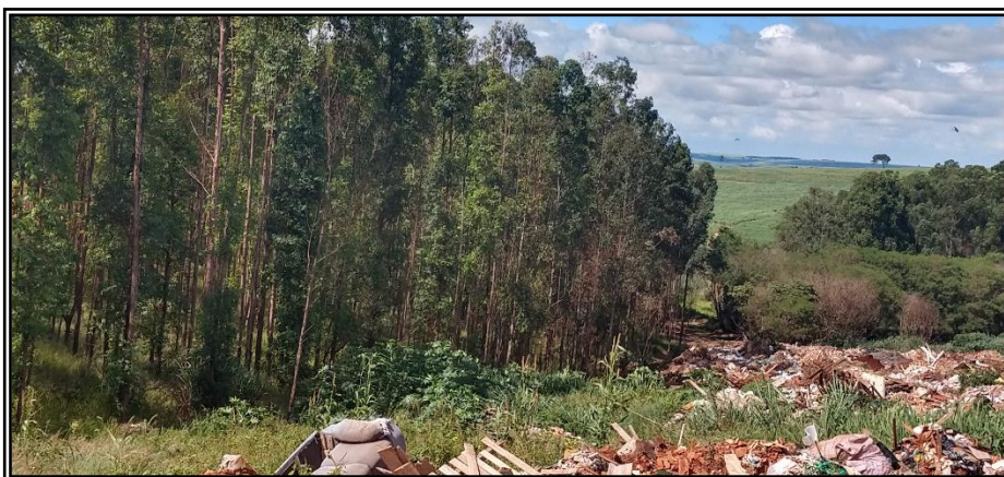
Foto 04: Visão Geral da área a receber descarte
